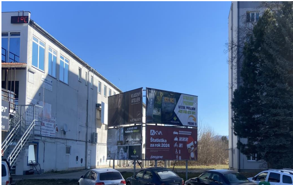
Príloha: dňa 19.02.2025 - fotosnímka reklamnej stavby na pozemku C KN parc. č. 3946/40 v katastrálnom území Prievidza
