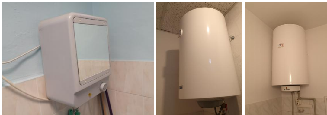
Obr. 10. Zásobníkové ohrievače pre prípravu TV
