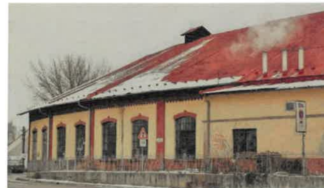
Rušňové depo v Prievidzi je v súčasnosti využívané na servis vlakových súprav.
