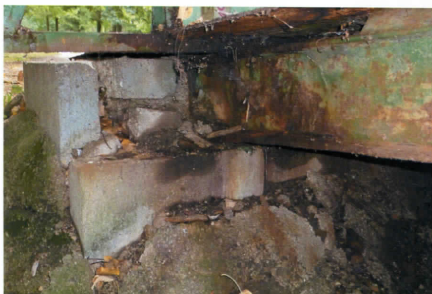
Obr. 9) Detail uloženia hlavného nosníka šikmej mostovky od Prievidze na základový blok s riešeným obetónovaním miesta kotvenia – pravá strana mostovky od Prievidze
