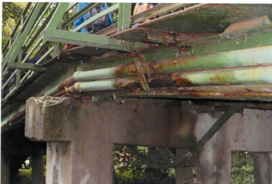
Obr. 7) Detail uloženia šikmej a líniovej časti lávky – nástupu od mesta Prievidza a viditeľné miesta korózie hlavného nosníka a potrubných rozvodov ukotvených ku konštrukcii lávky
