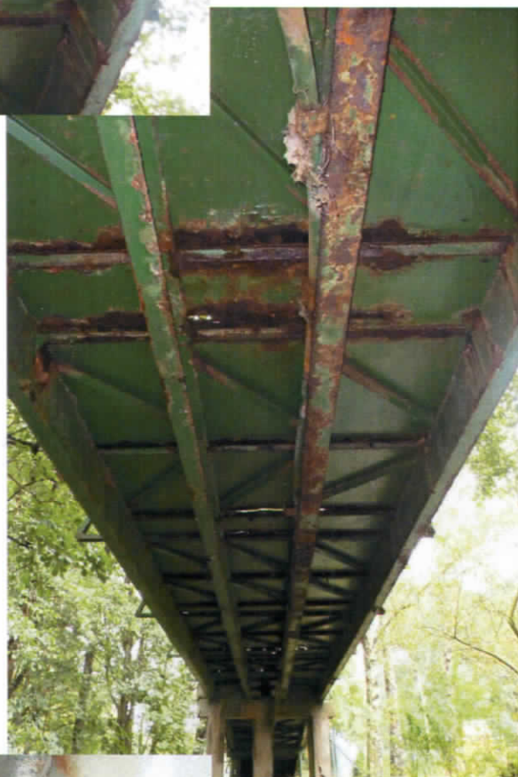
Obr. 10) Detailný pohľad na líniovú časť mostovky – s rozsiahlym vplyvom korózie na priehradový podperný (stužujúci) rám lávky, nosný rám zábradlia v tvare „U“ a hlavný nosník prierezu I300
