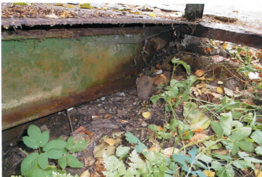
Obr. 18) Detail uloženia hlavného nosníka šikmej mostovky od Bojníc na základový blok s riešeným obetónovaním miesta kotvenia – ľavá strana mostovky od Bojníc
