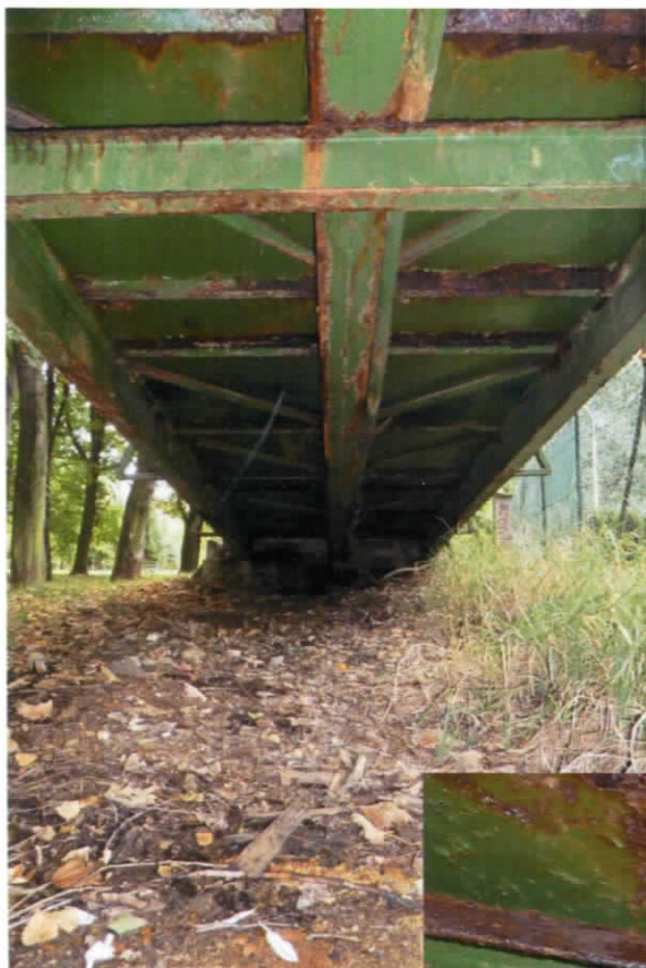
Obr. 4) Pohľad spodný na šikmú mostovku – nástupnú časť lávky od Prievidze s rozsiahlym vplyvom korózie na priehradový podperný (stužujúci) rám lávky
