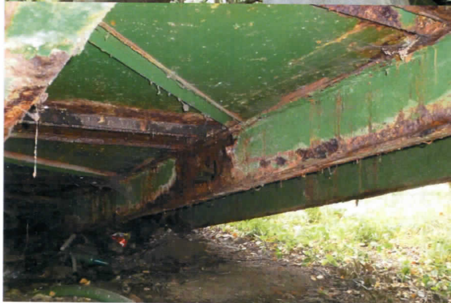
Obr. 15) Detailný pohľad spodný na šikmú mostovku – nástupnú časť lávky od Bojníc, s rozsiahlym vplyvom korózie na stredový nosník mostovky, prierezu I220
