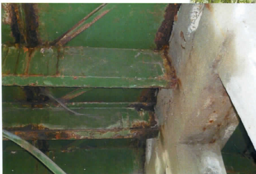
Obr. 12) Detail uloženia líniovej časti lávky – od mesta Bojnice s viditeľnými miestami korózie v časti uloženia hlavných nosníkov na ŽB podperný rám
