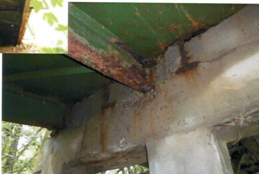
Obr. 14) Detail uloženia šikmej časti lávky – nástupu od mesta Bojnice a viditeľné uloženie stredovej časti lávky na ŽB podperný rám
