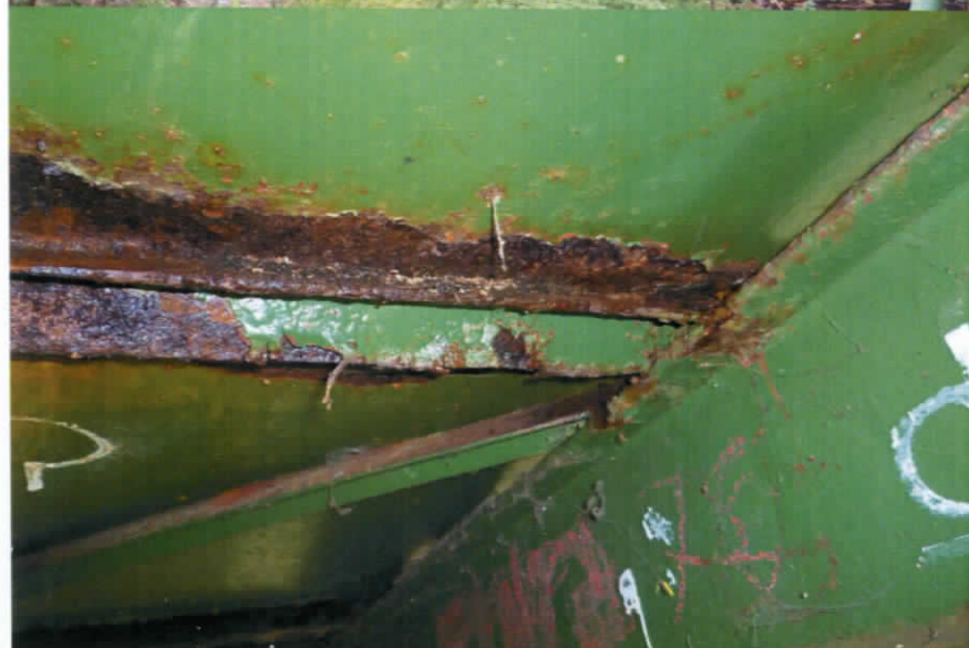
Obr. 3) Detail priehradov. podopretia pochôdzneho plechu s výstupkami – miesto navarenia (uloženia) plechu na stužujúci rošt lávky
