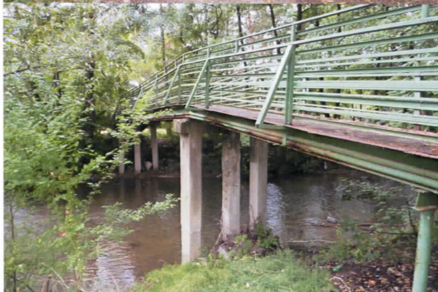
Obr. 2) Axonometrický pohľad na teleso lávky s betónovými podpernými piliermi – rámami stredovej časti lávky od Prievidze
