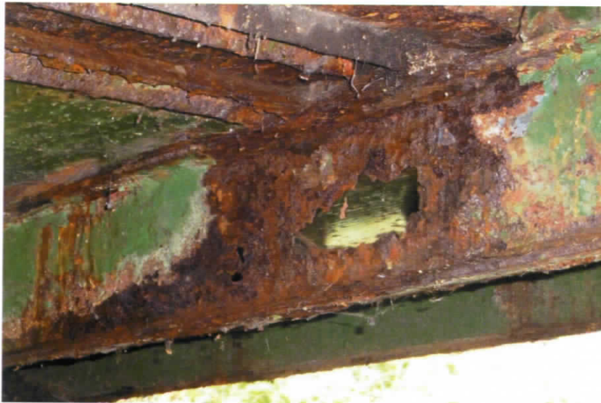
Obr. 16) Detailný pohľad na stredový nosník mostovky, prierezu I220 – degradácia materiálu stojiny nosníka a narušenie statickej funkcie v blízkosti uloženia šikminy lávky na základový blok
