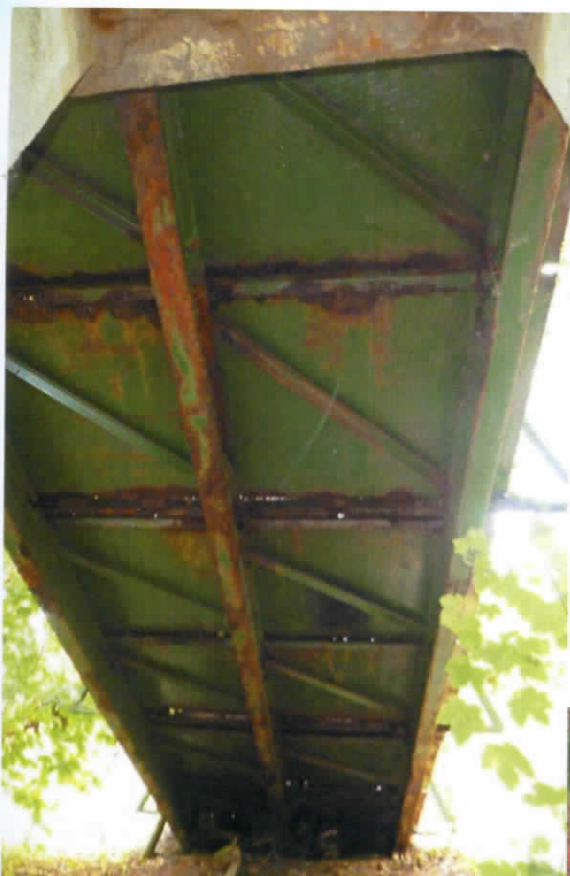
Obr. 13) Pohľad spodný na šikmú mostovku – nástupnú časť lávky od Bojníc, s rozsiahlym vplyvom korózie na priehradový podperný (stužujúci) rám lávky, na nosný rám zábradlia mostovky a s viditeľnými dierami v pochôdznom plechu šikmej mostovky
