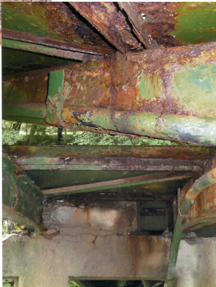
Obr. 5) Detail uloženia nosného rámu zábradlia v tvare „U“ – výrazný úbytok materiálu v dôsledku korózie
