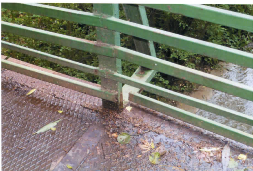
Obr. 21) Detailný pohľad na porušené uchytenie medzistípkovej výplne zábradlia
