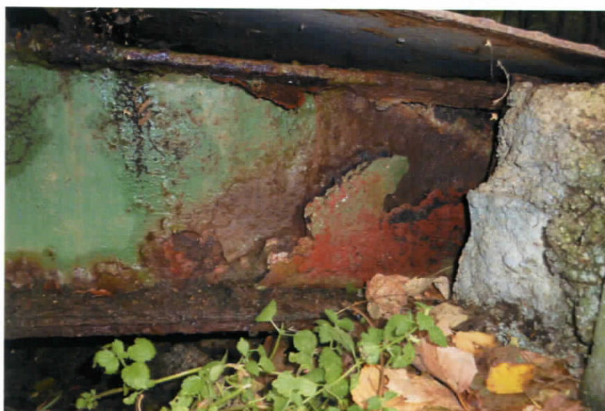
Obr. 8) Detail uloženia hlavného nosníka šikmej mostovky od Prievidze na základový blok s riešeným obetónovaním miesta kotvenia – ľavá strana mostovky od Prievidze
