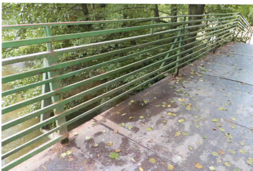
Obr. 20) Pohľad na skutkový stav zábradlia lávky a jeho medzistípkovú výplň – pohľad na chýbajúci dolný pás zábradlovej výplne
