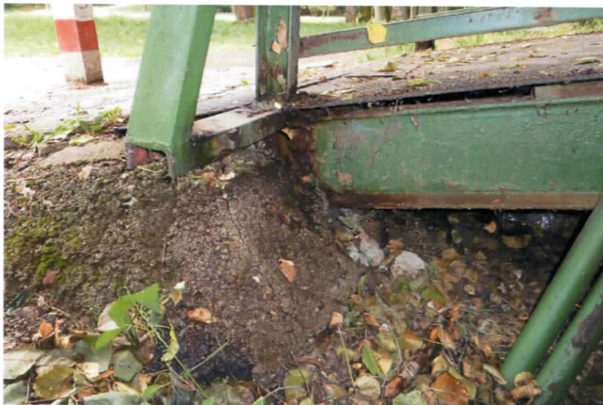
Obr. 17) Detail uloženia hlavného nosníka šikmej mostovky od Bojníc na základový blok s riešeným obetónovaním miesta kotvenia – pravá strana mostovky od Bojníc
