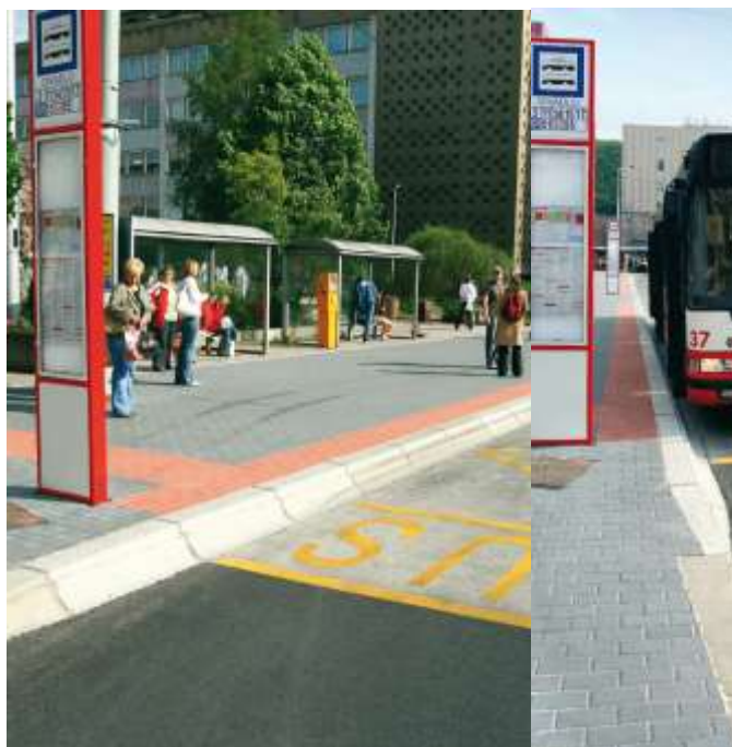
Obr. 9.2.14 Bezbariérové zastávky MHD - detail Kasselský obrubník
